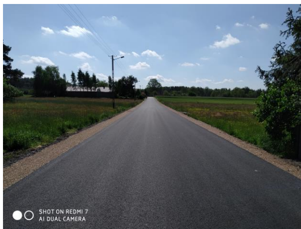
Zdjęcie 6 Przebudowa drogi w m. Pieńki Głupickie
