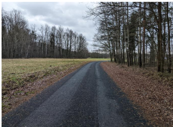
Zdjęcie 2 Modernizacja drogi gminnej w m. Patok
