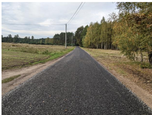
Zdjęcie 7 Modernizacja drogi w m. Zabiellów
