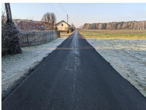
Zdjęcie 5 Modernizacja drogi w m. Zalesie
