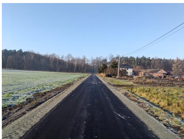
Zdjęcie 4 Modernizacja drogi w m. Suchcice
